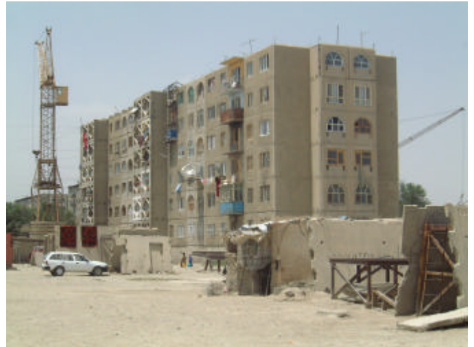
写真 4 屋上が未完成の中層住宅
