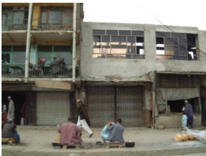
写真 6 上階が利用されていない商業施設
